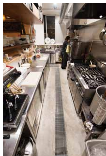
■ 中央に排水溝を通し、水はけを改善したキッチン。通路も広くとっており、スタッフが交錯しても安心
