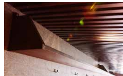
■荷物置きは視線を邪魔しないように高めに設置
