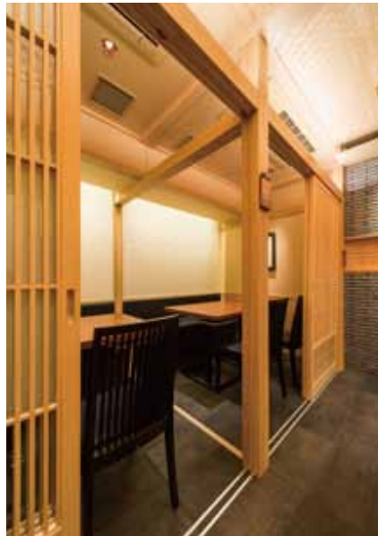
■ 可動式壁を取り外した個室 可動式壁は簡便に取り外して設置することができる
