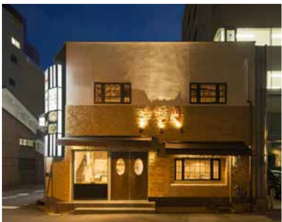
■外観 四方から見える角に壁面サインと突き出し看板を設置し集客力アップ
