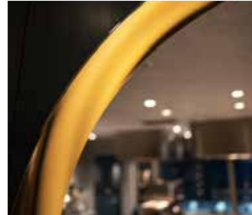
■ エントランスのアーチ 光を反射して輝く真鍮メッキ塗装が美しい
