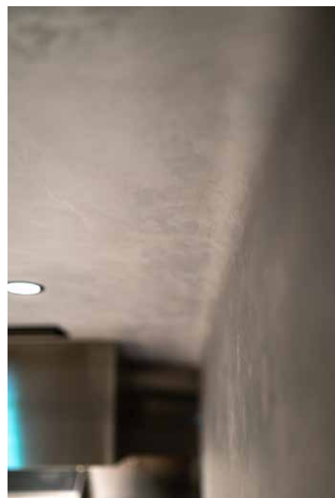
■ 洞窟をイメージして壁面と天井の合わせはアール仕上げに
